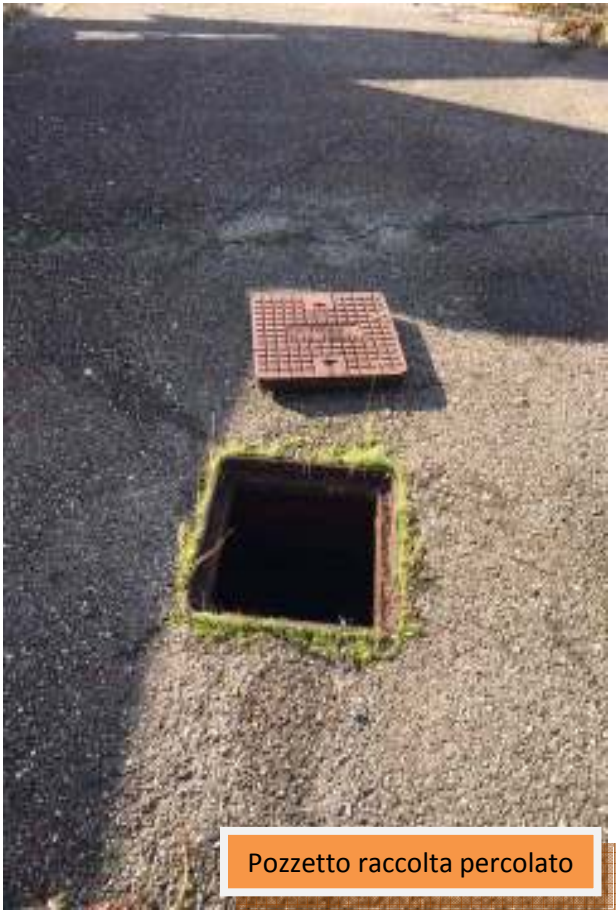
Vista ex impianto di compostaggio
