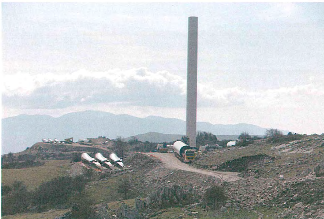
Foto 11 - Veduta panoramica dell'area fortemente alterata da strade, piazzole ed aree di manovra e stoccaggio (previsto ???), attorno ai pavimenti calcarei (habitat 8240*) delle foto 9 e 10 (visibili a destra nella foto)
