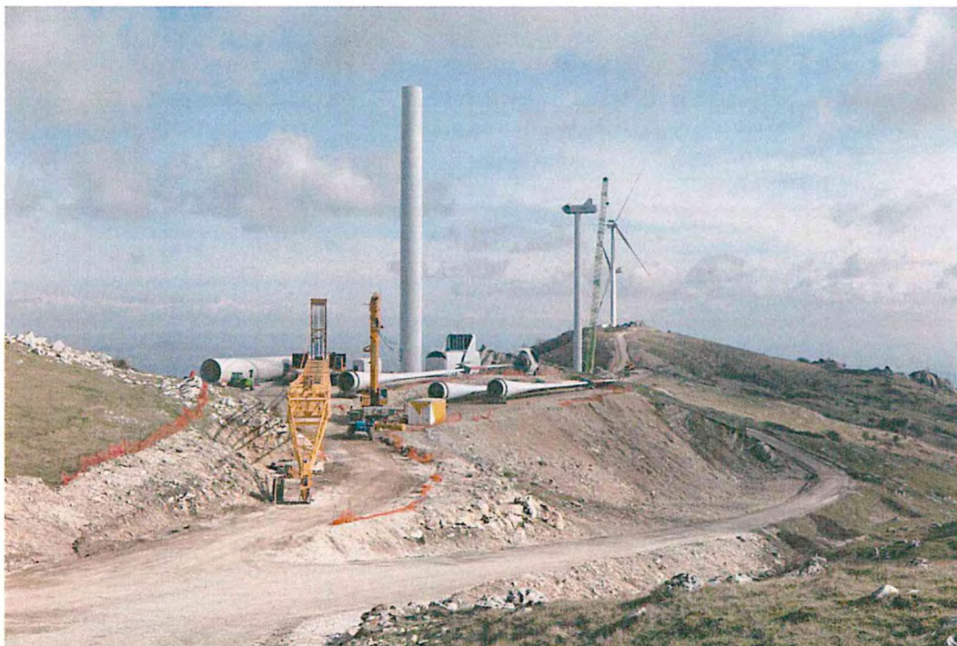
Foto 5 - Spianamento dei versanti e accumulo del materiale sugli habitat di Direttiva 6110*, 6210 e, potenzialmente, 6210*.
