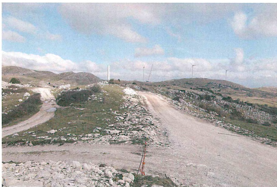
Foto 4/4 bis - Alterazione del paesaggio, con costruzione di nuove piste con larghezza variabile da 6 a 12 metri e oltre nelle curve, abbandono del vecchio tracciato sterrato e scavi e depositi di materiali inerti di diversa provenienza ai lati delle piste con distruzione (asportazione, seppellimento o rimaneggiamento) degli habitat di Direttiva 6110*, 6210 e, potenzialmente, 6210*.
