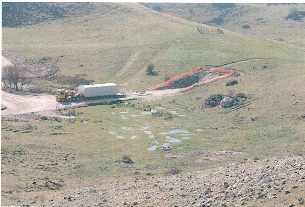
Foto 15 – Vista panoramica dell’ambiente umido con habitat di risorgiva e giuncheti tagliato in più parti da nuove strade e da uno sbancamento; si può notare anche la distruzione della pista esistente, che conduceva alla adiacente vallecola dove sono ubicate le sorgenti del Torrente Lente (Fontana Acqua della Lepre)
