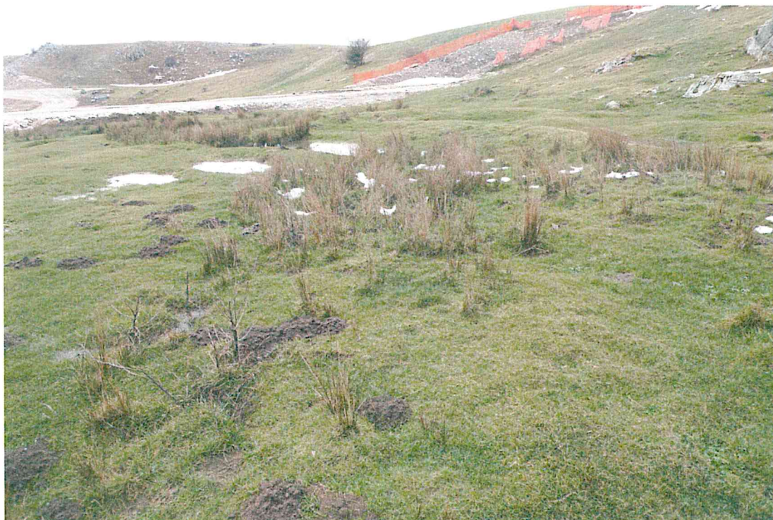
Foto 14 - L'ambiente umido con giunchi tagliato e tombato per realizzare una area di manovra
