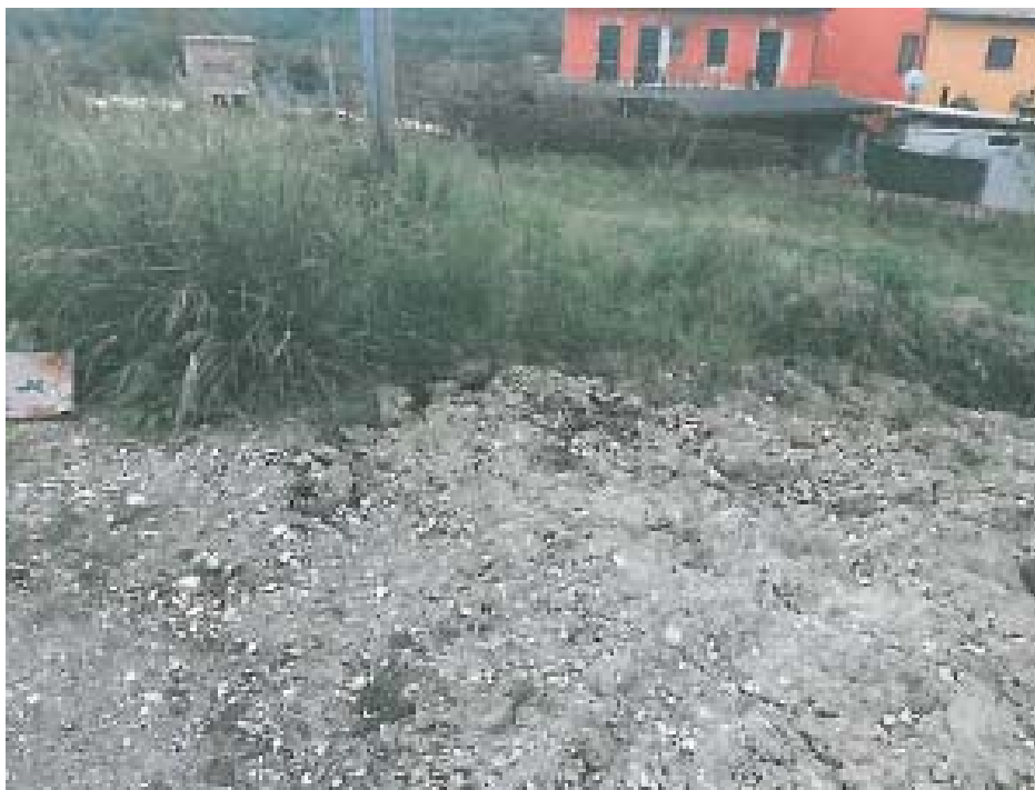
Intervento di ripristino della condotta idrica da parte dell'Ente acquedottistico Alto Calore spa
