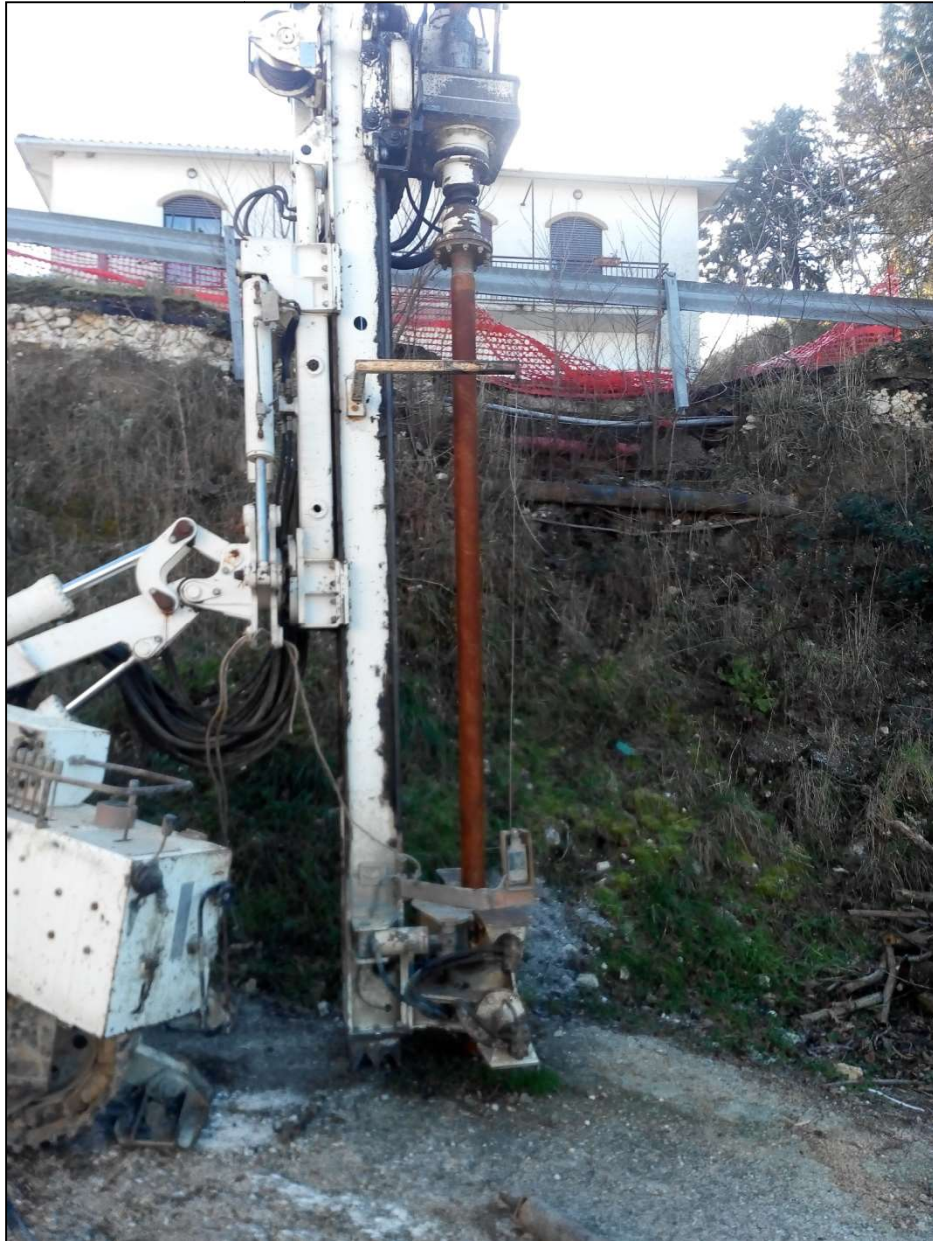
Foto n.°2: Postazione sondaggio S1
