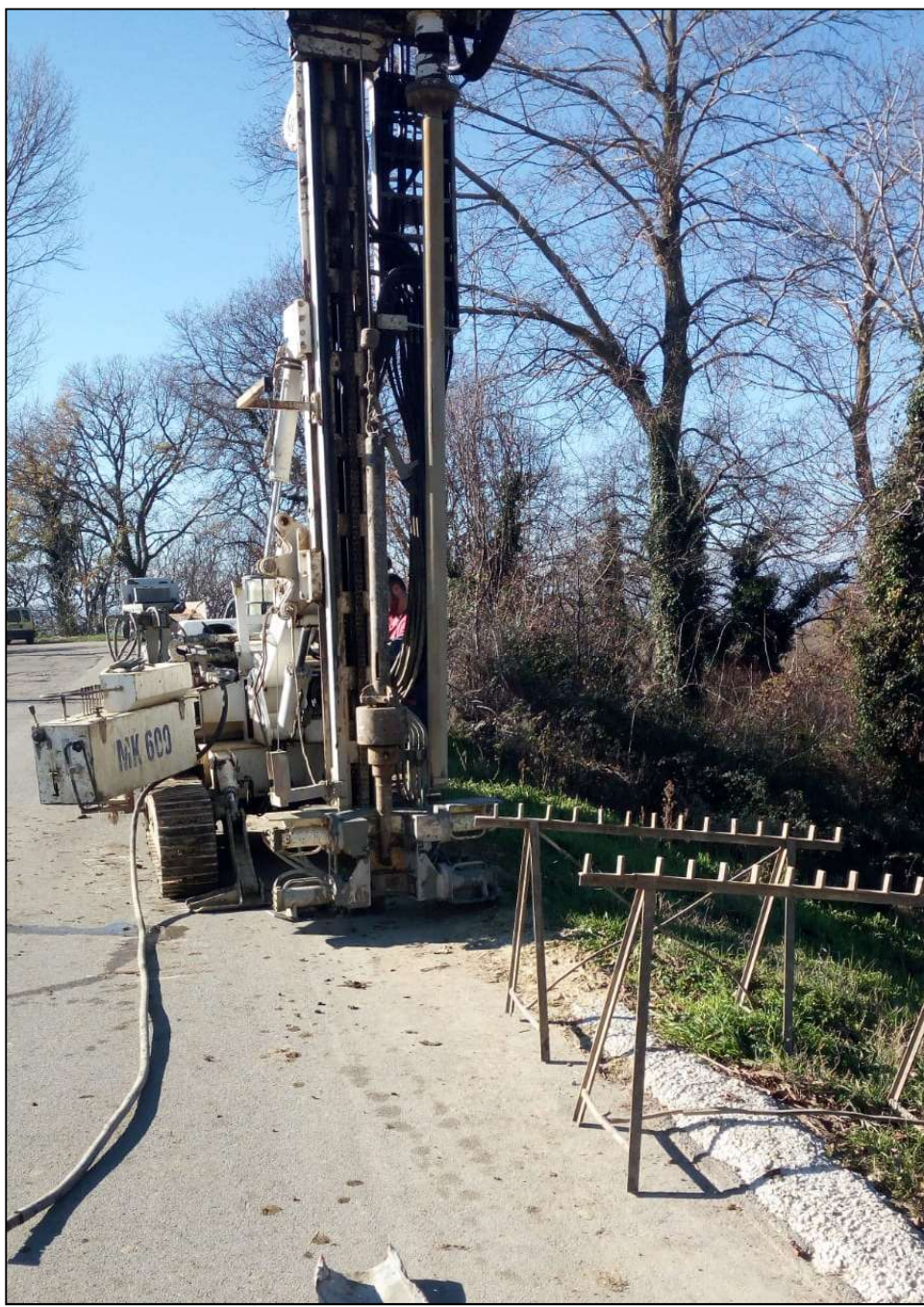
Foto n.°2: Postazione sondaggio S3
