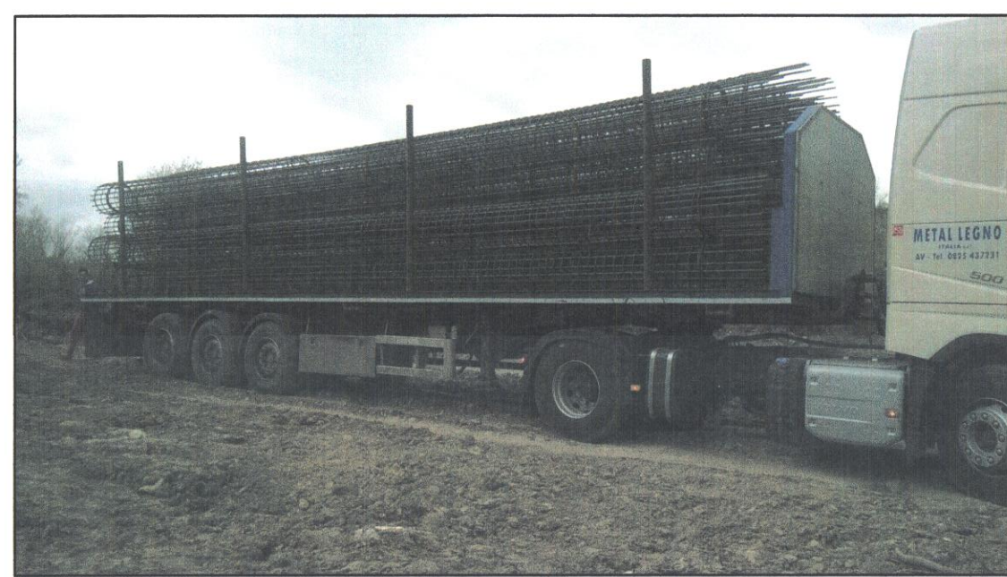
foto 2: "armature pali platea gabbionata"
