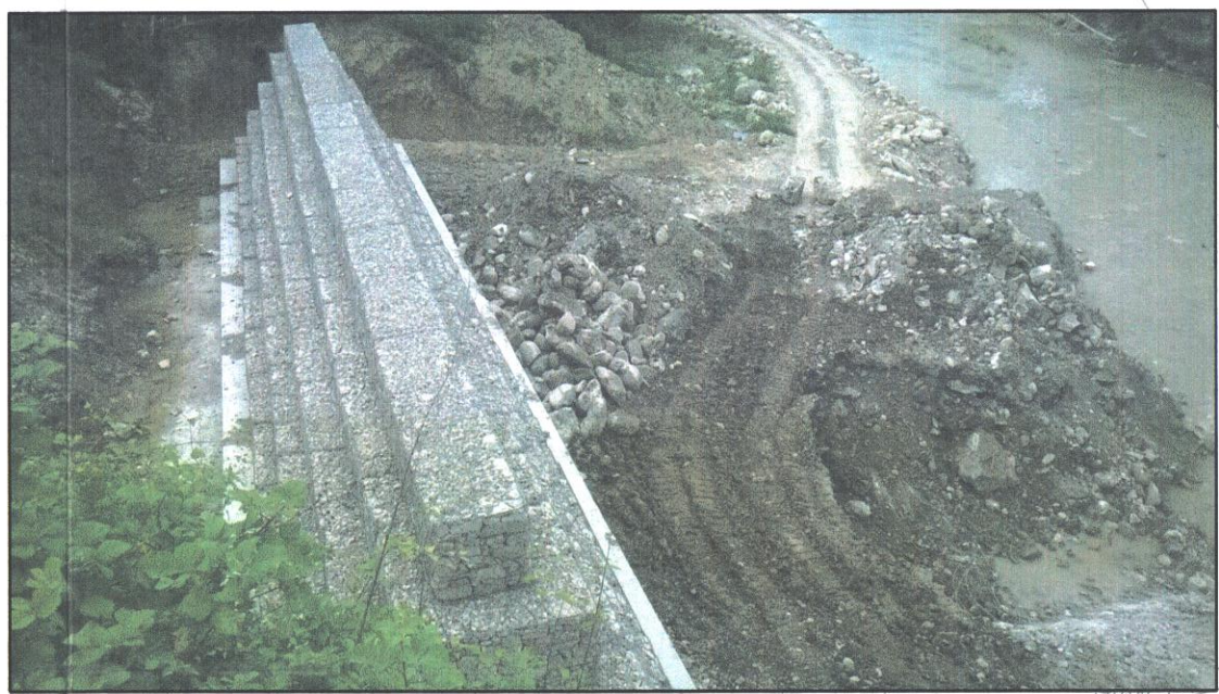
foto 4 e 5: "gabbionata in sx idraulica"
