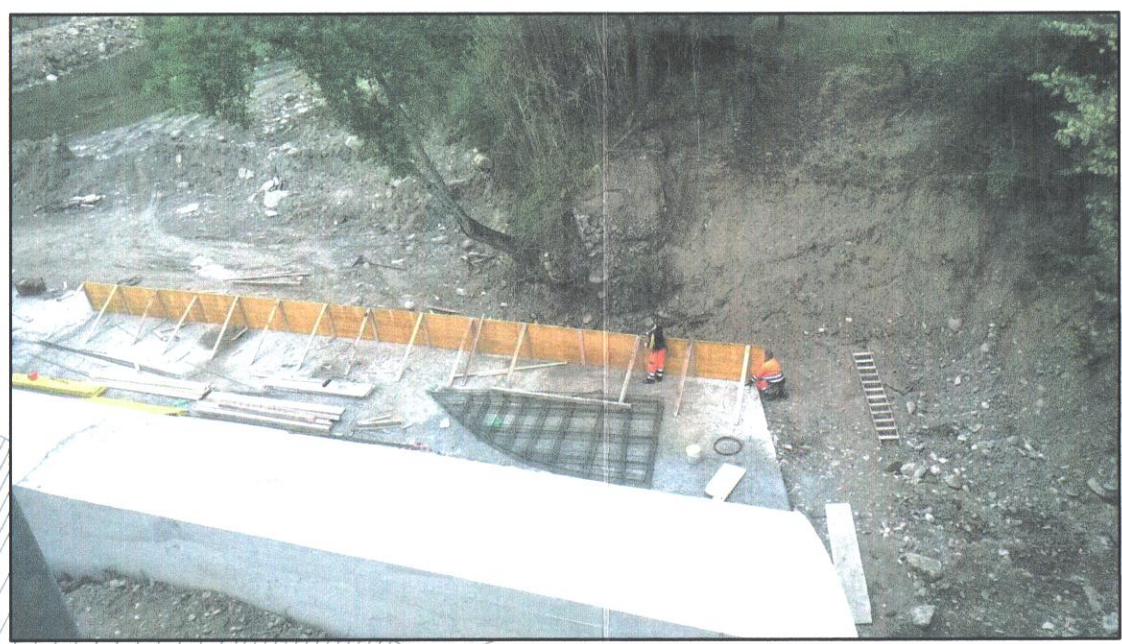
foto 6: "area gabbionata in dx idraulica adiacente la briglia"
