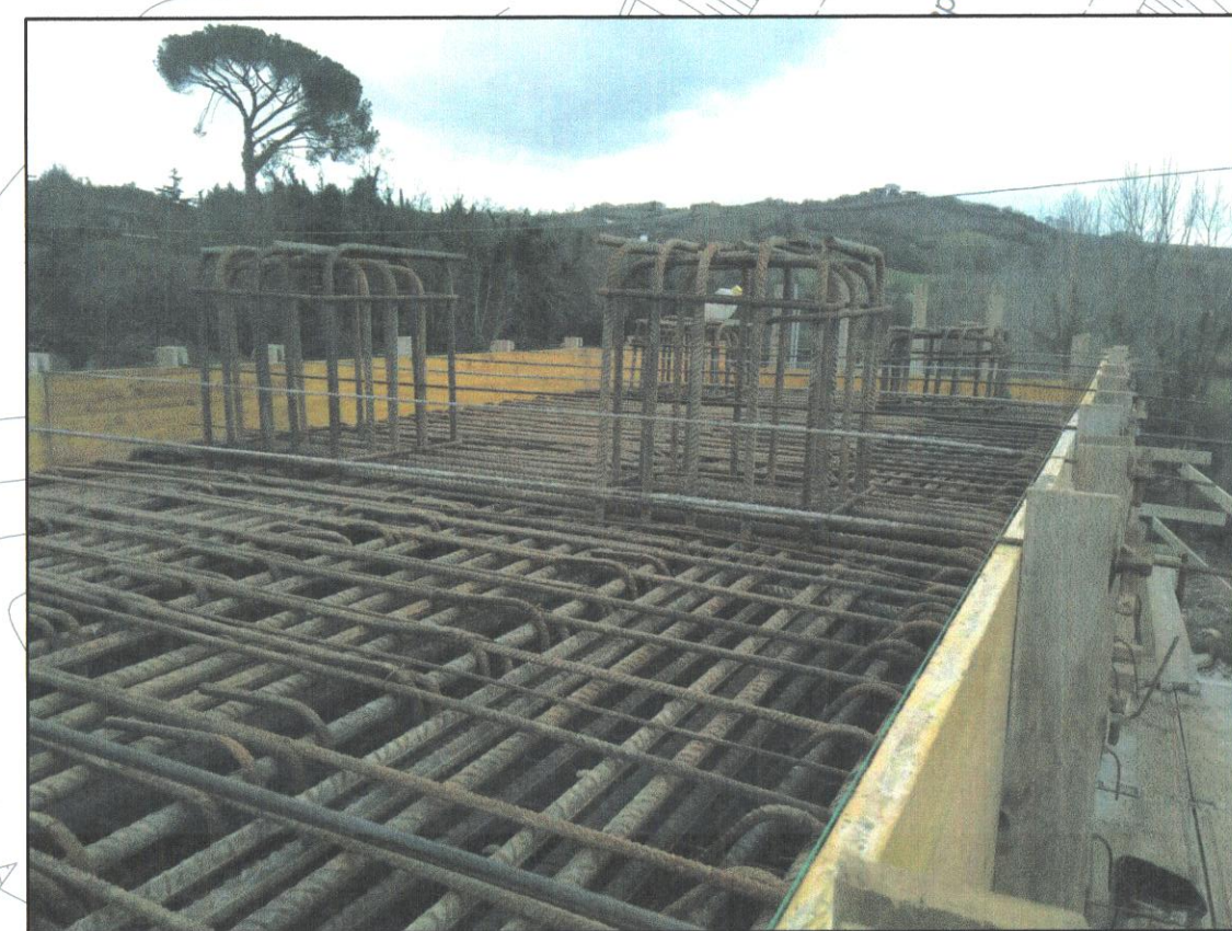
foto 9: "particolare armatura baglioli e pulvini"
