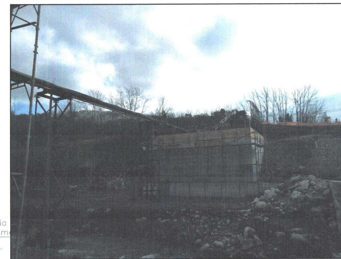
foto 8: "spalla A in dx idraulica"
