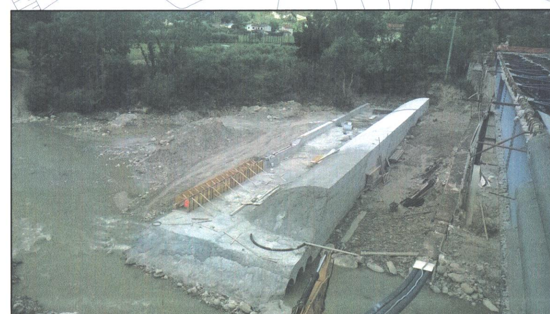
foto 7: "vista dall'alto della briglia a valle del ponte"
