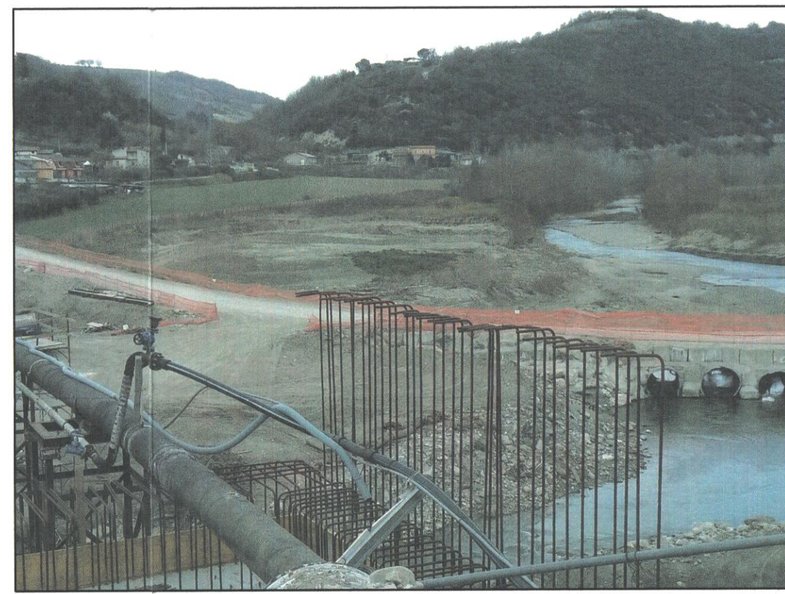
foto 14: "area di piena a monte del ponte"
