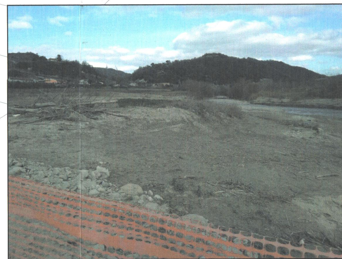
foto 13: "area di piena in dx idraulica a monte del ponte"
