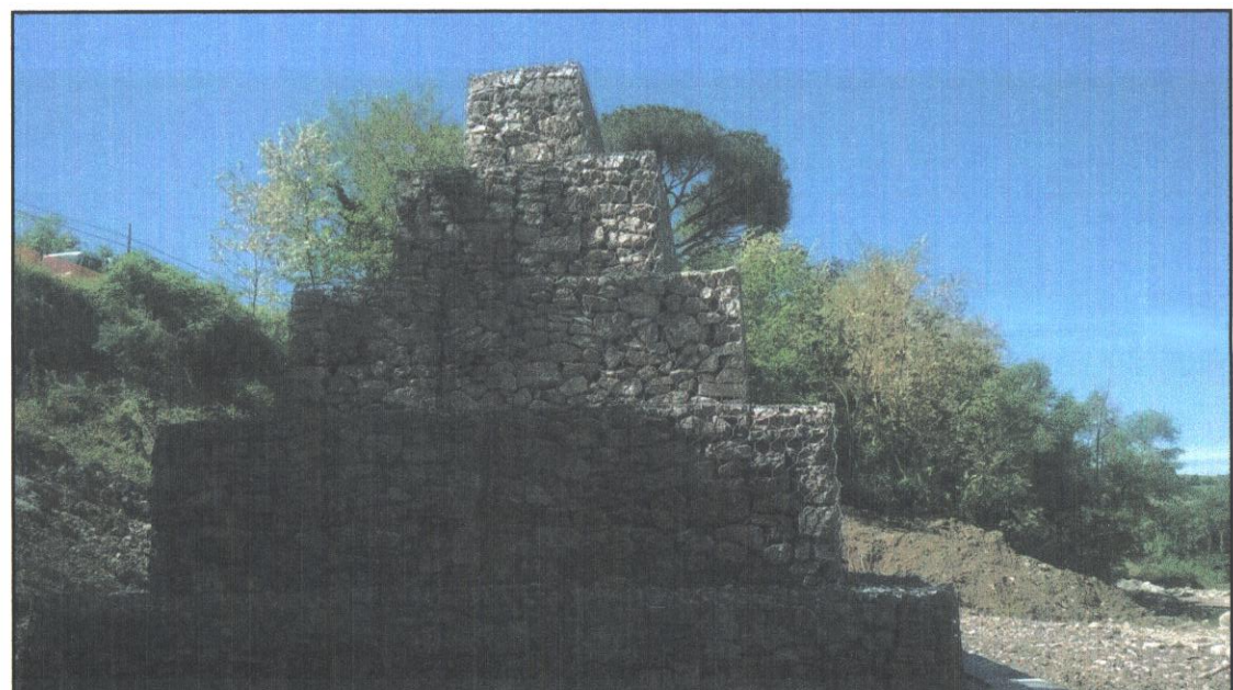
foto 4 e 5: "gabbionata in sx idraulica"
