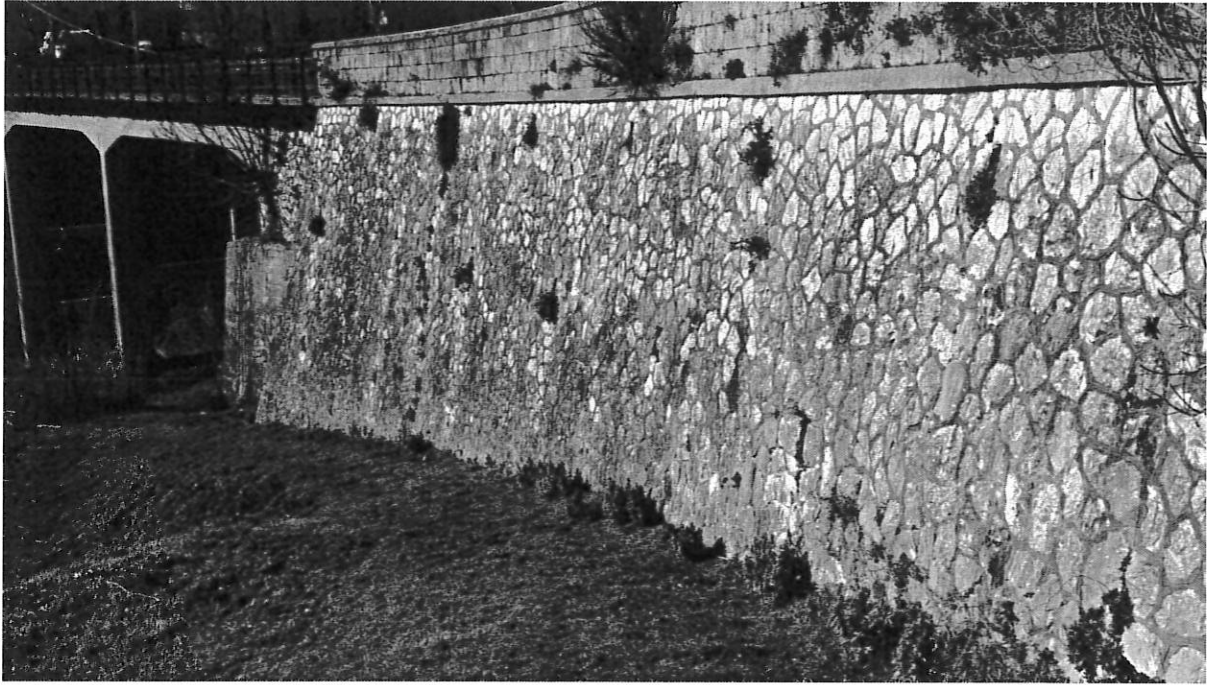
Vista della spalla in muratura
