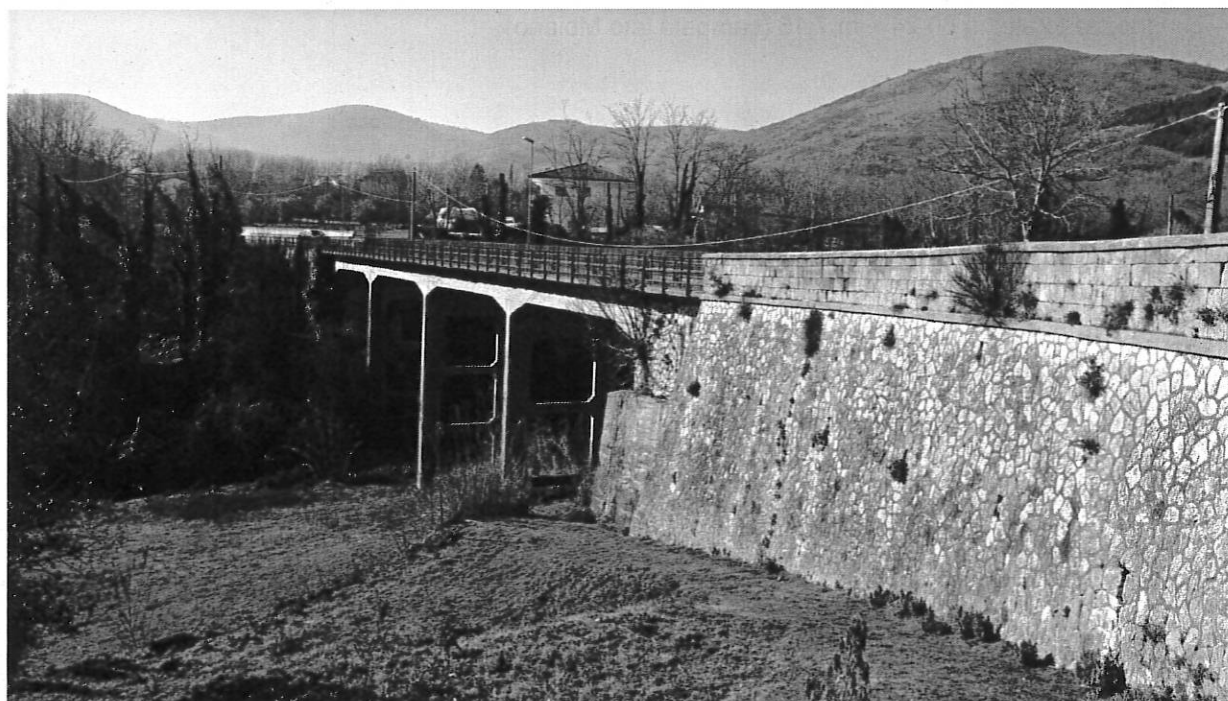
Vista d'insieme da lato opposto Moiano con spalla
