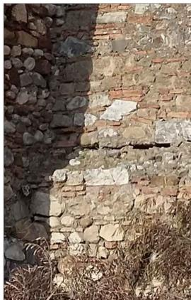
Analisi del degrado: fenomeni di dissesto e dislocazione della tessitura muraria, con rotture e con scorrimento di settori di murature basamentali e perdite localizzate degli elementi lapidei, sfaldamento e degradazione dei letti di malta a causa della degradazione dei terreni e dei materiali, finalizzate al consolidamento in fondazione ed elevazione.
