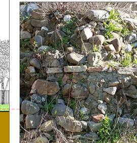
Analisi del degrado: erosione dello strato esterno di fondazione della torre cilindrica angolare, a causa dello scalzamento della stessa fondazione e della conseguente abrasione degli strati corticali provocata dagli agenti atmosferici e dagli agenti inquinanti.
