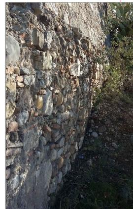
Analisi del degrado: fenomeni di sfaldamento e dislocazione della tessitura muraria basamentale; sfaldamento e degradazione dei letti di malta a causa della scalzamento di parte delle fondazioni.
