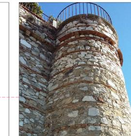
Analisi del degrado: distacco degli elementi lapidei costituenti la pavimentazione della torre cilindrica e conseguente infiltrazione di acque meteoriche con nascita di vegetazione infestante; rotture e perdite localizzate di elementi aggettanti in laterizio.
