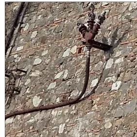
Analisi del degrado: presenza di vecchie tubazioni agganciate al paramento murario attraverso mensole di ferro.
