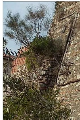
Analisi del degrado: presenza di vegetazione infestante causata dalle infiltrazioni d'acqua provenienti dal piano orizzontale del barbacane, privo di protezione e di manutenzione, e dal vano interrato retrostante il muro (che prende accesso da una botola con grata a livello del giardino) e presenza di vuoti nel paramento murario.
