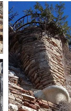
Analisi del degrado: distacco degli elementi lapidei costituenti la pavimentazione dello sporto poligonale e conseguente infiltrazione di acque meteoriche con nascita di vegetazione infestante; rotture e perdite localizzate di elementi aggettanti in pietra e in laterizio.
