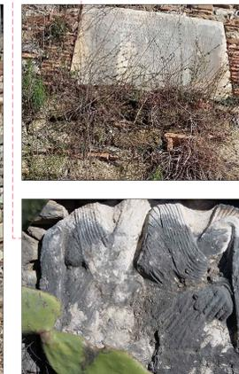
Analisi del degrado: distacco degli elementi lapidei costituenti la pavimentazione dello sporto poligonale e conseguente infiltrazione di acque meteoriche con nascita di vegetazione infestante; rotture e perdite localizzate di elementi aggettanti in laterizio.
