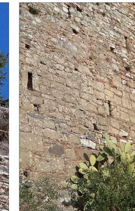
Analisi del degrado: fenomeni diffusi di occlusione e/o di generale deterioramento dei fori drenanti causati da mancanza di manutenzione e da possibili dissesti locali all'interno della massa muraria, non direttamente riscontrabili con indagini visive.
