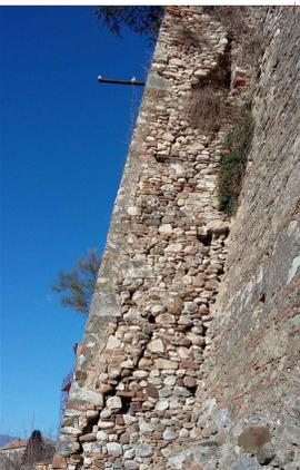
Analisi del degrado: fenomeni di dissesto e dislocazione della tessitura muraria, con rotture e con scorrimento di settori di murature del contrafforte e perdite localizzate degli elementi lapidei, sfaldamento e degradazione dei letti di malta a causa delle infiltrazioni delle acque meteoriche; presenza di vecchie tubazioni impiantistiche agganciate al paramento murario con mensole di ferro.
