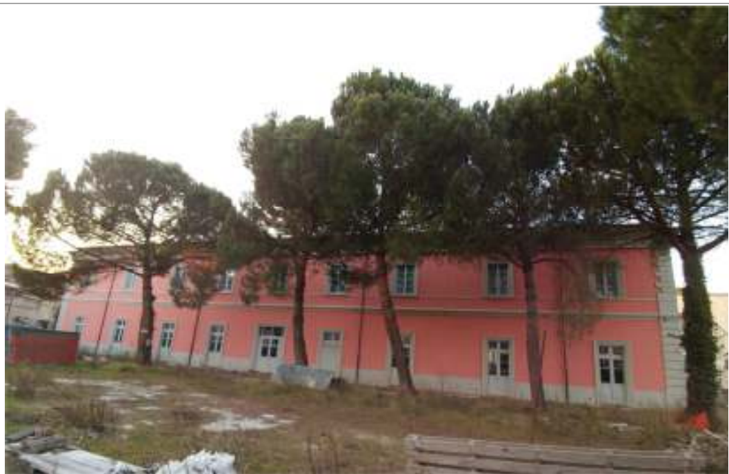
Figura 7 Stato di fatto Prospetto anteriore su Piazza d'Armi
