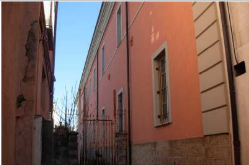
Figura 9 Stato di fatto Prospetto posteriore su Via XXIV Maggio
