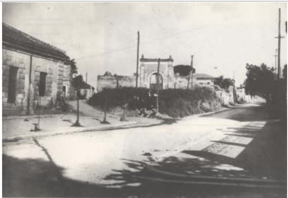
Figura 4 La Caserma Sannitica ai primi del '900, scorcio dell'edificio "B" sul Via le degli Atlantici, angolo Via T. Ferrelli
