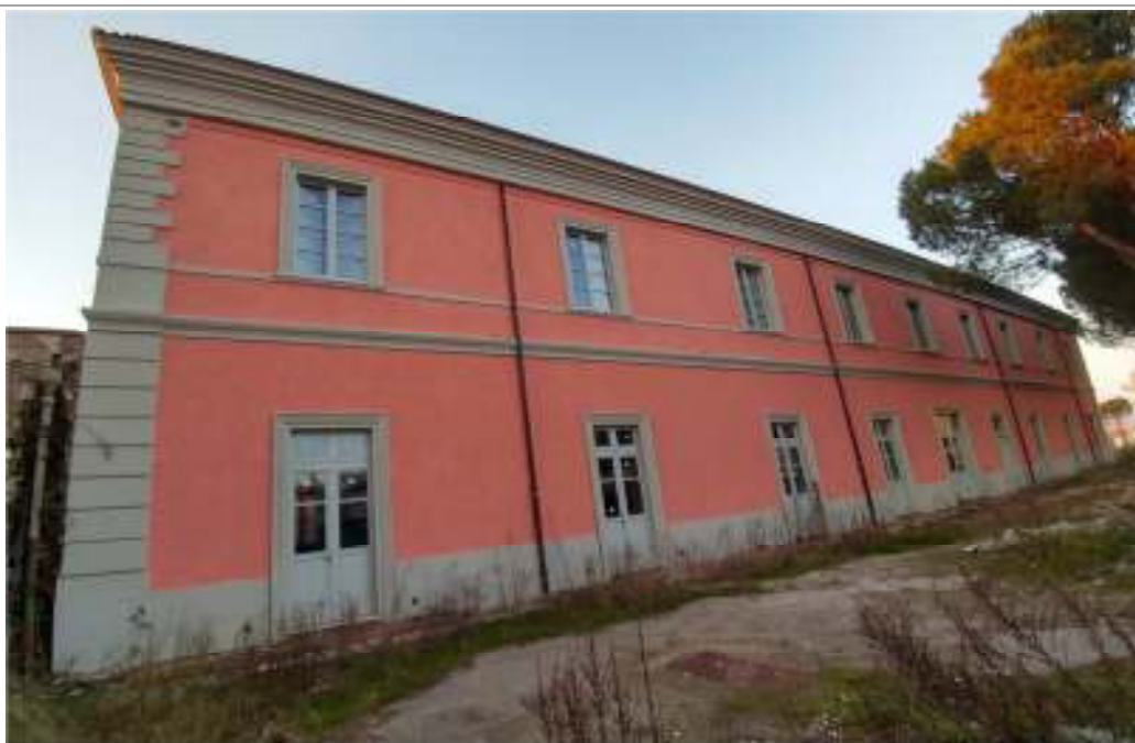
Figura 6 Stato di fatto Prospetto anteriore su Piazza d'Armi
