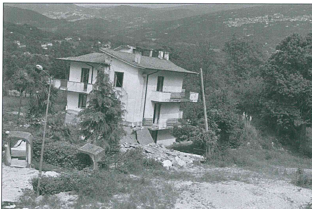
Figura 3.4 Immagini del dissesto sulla SP1 – vista su edifici dissestati
