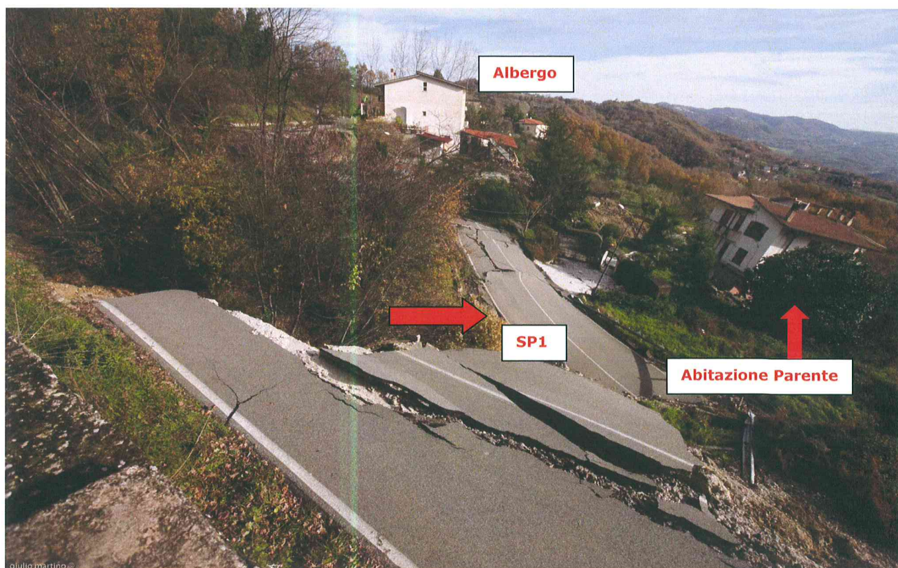
Figura 3 – Strada SP1 e versante dopo la frana (foto satellitare del 2007)
