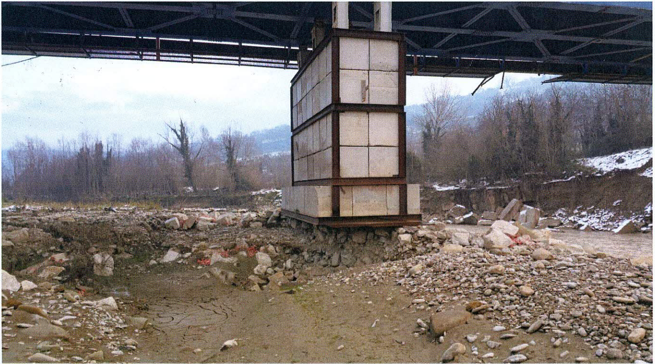
Pila del ponte
