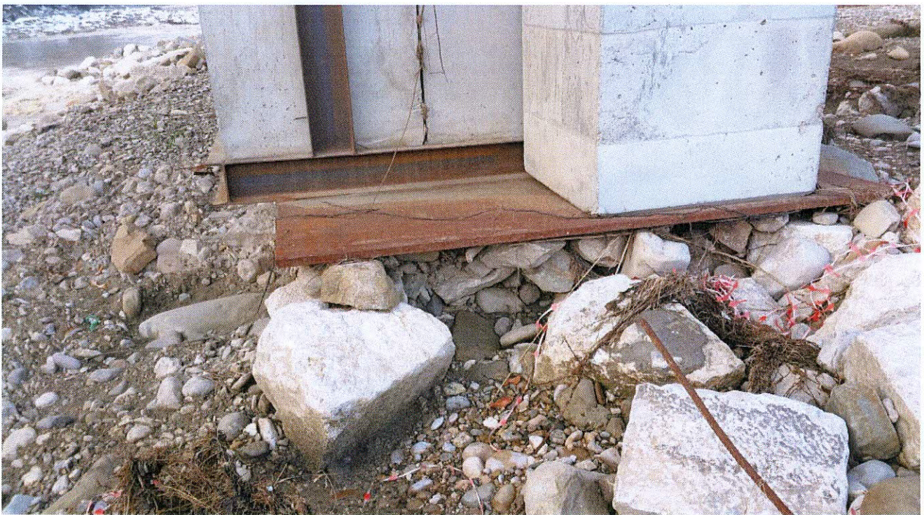
Particolare della pila
