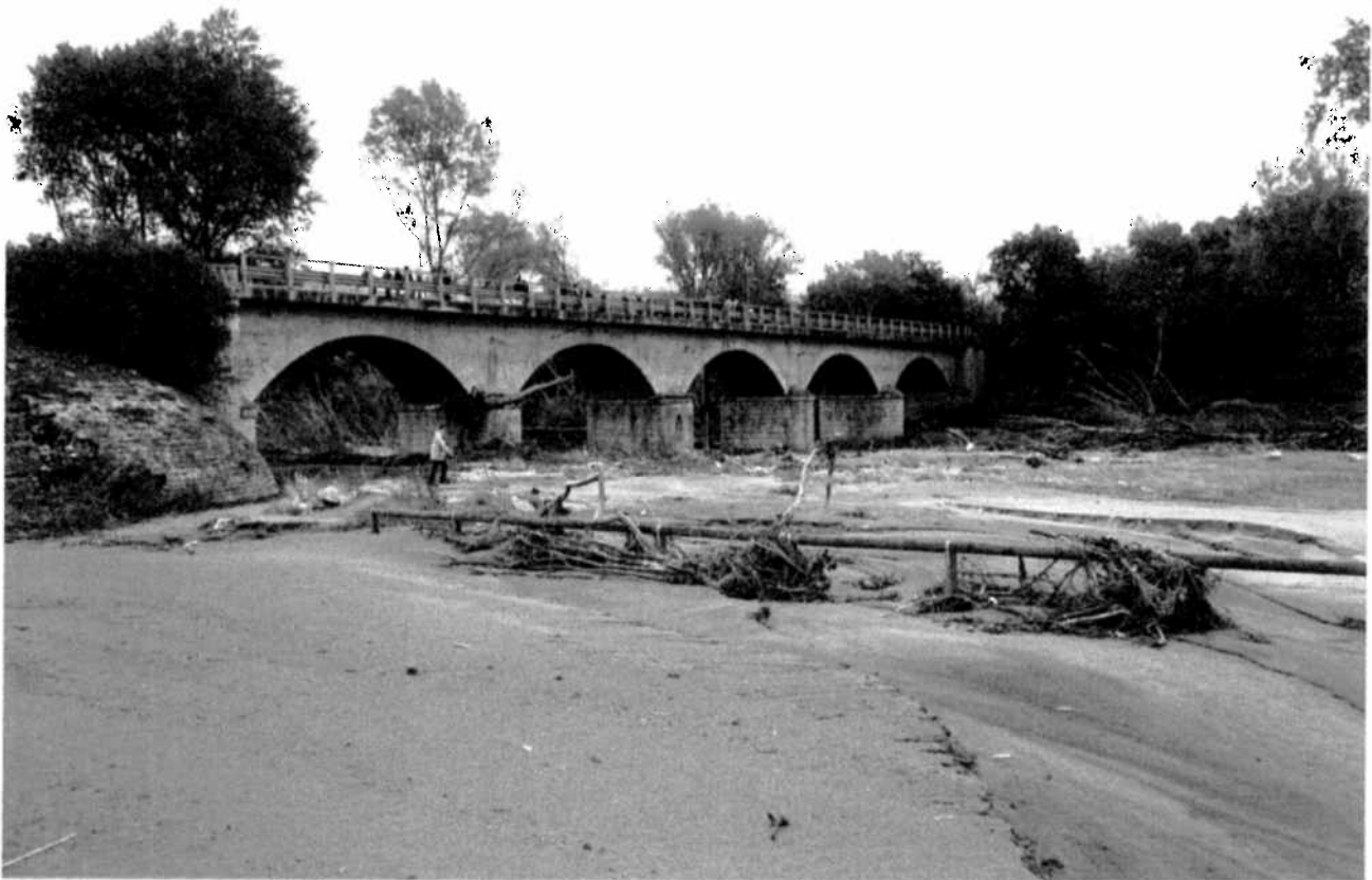
Particolare dell'innalzamento livello fluviale a monte del Ponte
