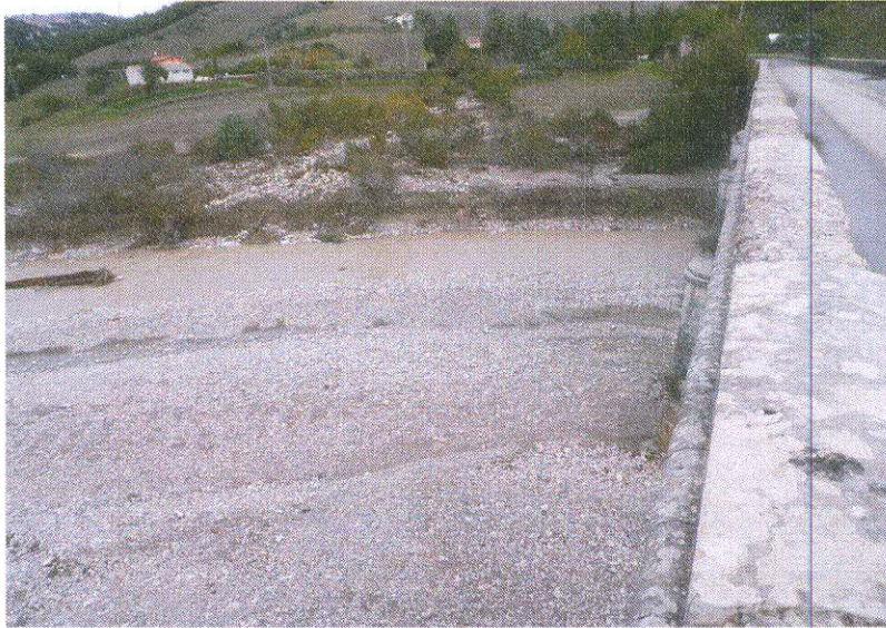
Fig. 4 – Ponte Setteluci – San Bartolomeo in Galdo
