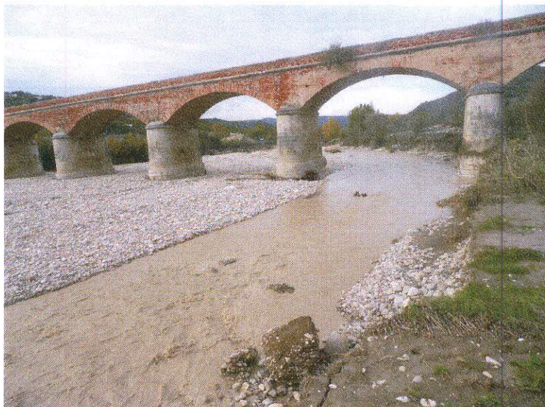
Fig. 3 – Ponte Setteluci – San Bartolomeo in Galdo
