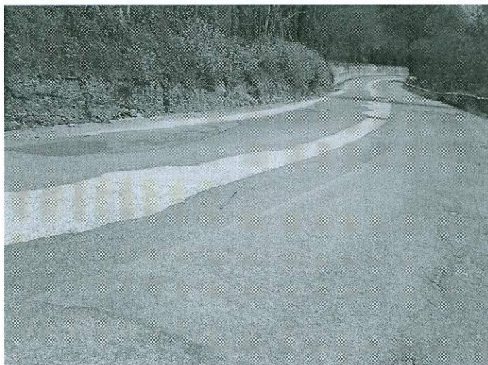
Figura 1 – traccia della canalizzazione della rete metano
